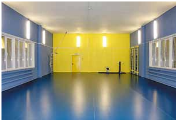
◆ Ремонт спортзала в Лопшеньге
